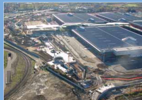
Lavori per il prolungamento della linea 1 della metropolitana.
