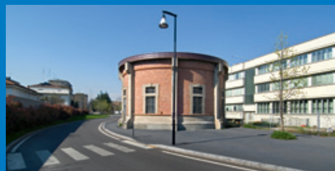
Veduta degli uffici del centro amministrativo di Cinisello Balsamo, Milano
