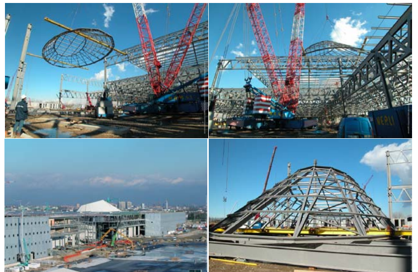
Fasi di montaggio del lucernario sul padiglione biplanare
